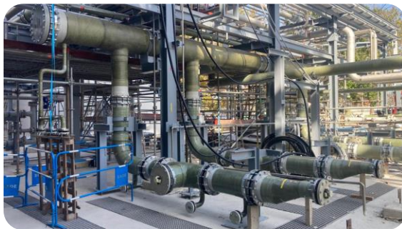
Réalisation d'une pomperie en SVR DN 700 & 500
